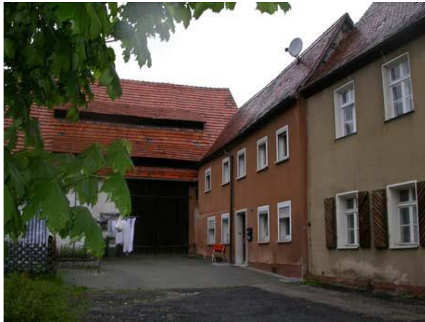
Pilotprojekt Nürnbergger Straße 18/20, Scheune © Markt Schnaittach
