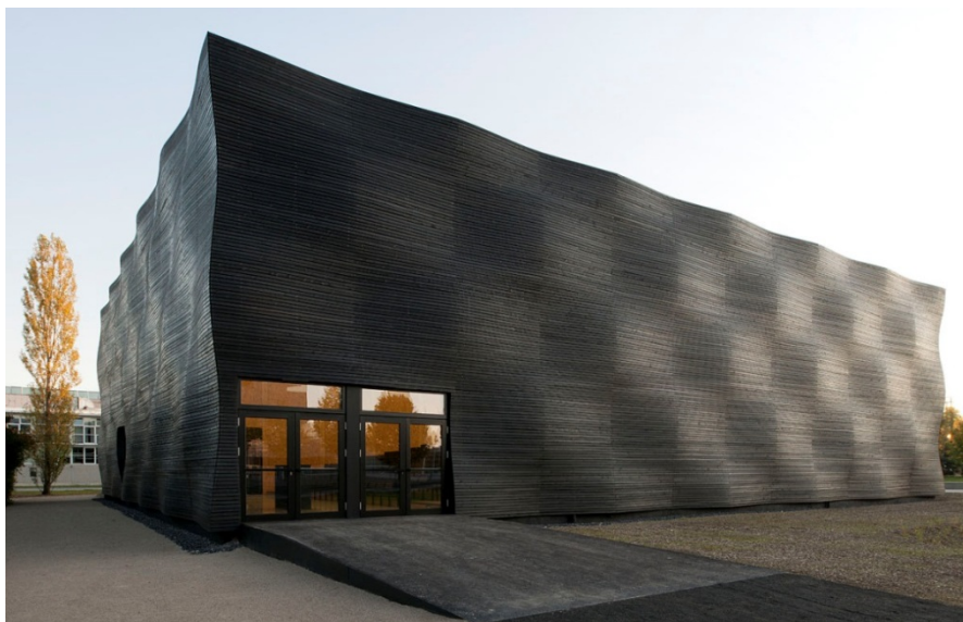
Ansicht Hörsaalgebäude (Foto: Henning Köpke, München)
