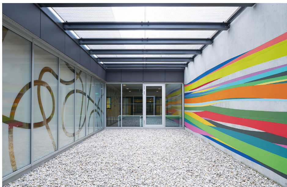
„Kunst am Bau“ in einem Lichthof, der das Foyer, den Sitzungssaal und die Haftbereiche verbindet. Die Arbeit „Licht und Schatten“ wurde im Zuge eines Wettbewerbs ausgewählt. © Stefan Müller-Naumann, München
