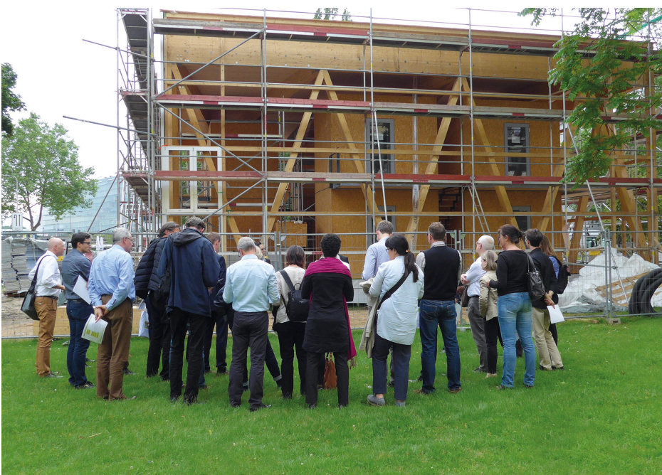
Oben: Die erste Station der Fortbildungsreise war die staatliche Wohnanlage im unterfränkischen Karlstadt, die im Rahmen des staatlichen Sofortprogramms (Wohnungspakt Bayern) gebaut wurde. Unten: Die Exkursionsteilnehmer besichtigen das Projekt „CUBITY“, ein Studentenwohnheim im Stadtteil Frankfurt-Niederrad. © Beide Fotos: Günther Gruber, Regierung von Niederbayern
