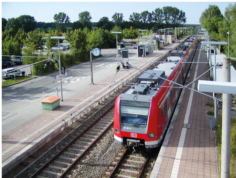
Park & Ride Parkplatz (links im Hintergrund) der Station Hallbergmoss an der Linie S8 zum Flughafen in München. Die Stellfläche entlastet den Parkplatz am Flughafen sowie den Zufahrtbereich. © MVV GmbH
