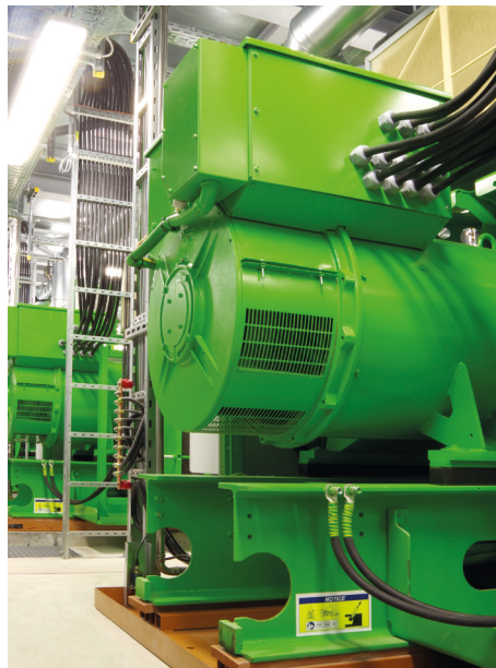
Im Blockheizkraftwerk des Klinikums Großhadern kommen Gas-Otto-Motoren zum Einsatz. © Rögelein Ingenieurgesellschaft mbH
