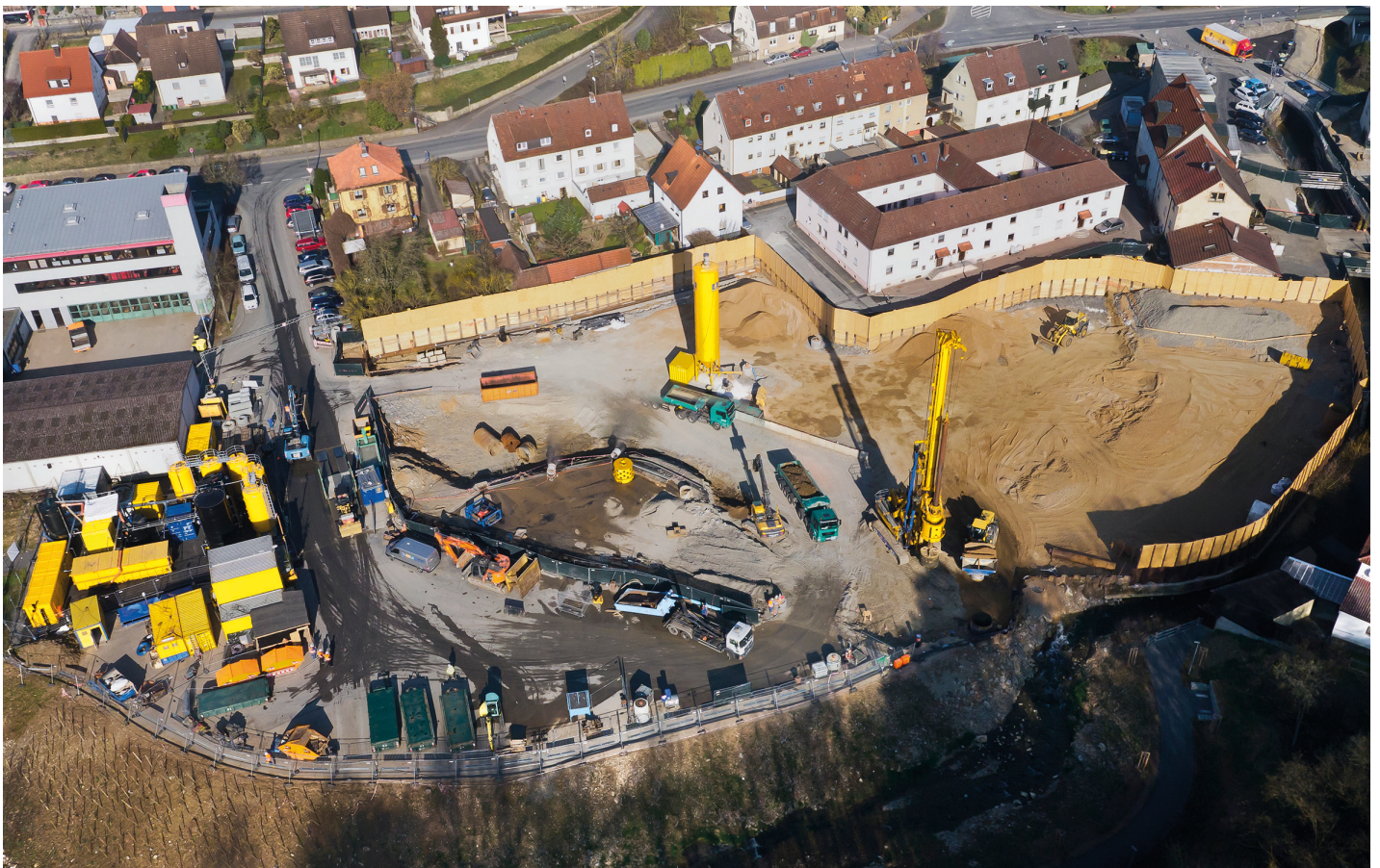
Das Altlastengebiet Schonungen im Landkreis Schweinfurt. Fast 140.000 Tonnen kontaminierter Boden musste ausgehoben werden. Auf der Basis von 20.000 chemischen Analysen wurden gravierende Verunreinigungen der Böden und des Grundwassers nachgewiesen. © Bauer AG, Schrobenhausen
