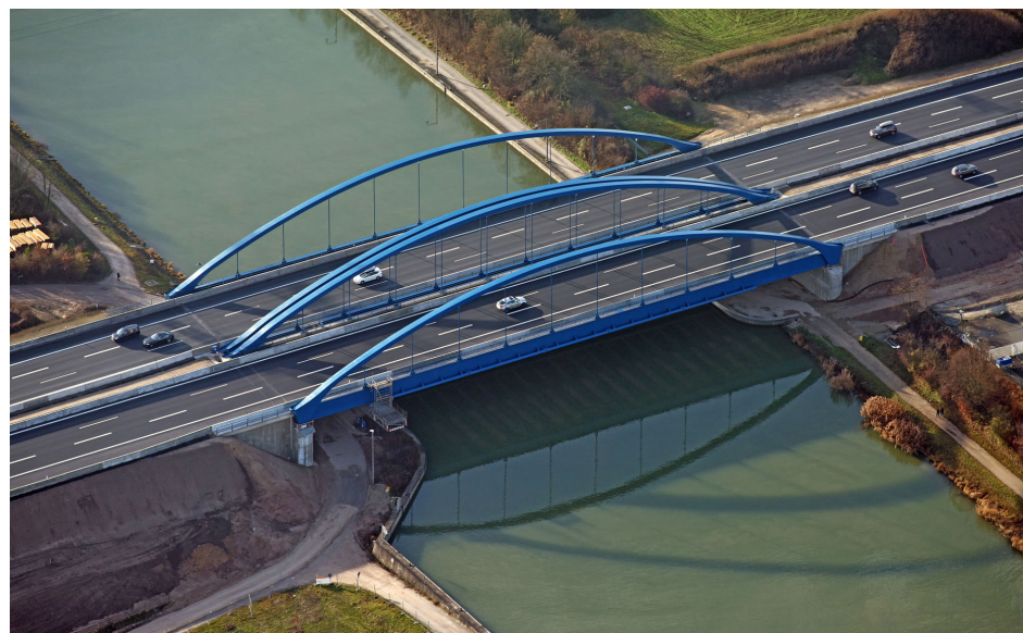
Die Main-Donau-Kanalbrücke im Zuge der A 3 wurde im Dezember 2015 fertiggestellt. Für den weiteren Ausbau der A 3 ist im Oktober 2016 das Vergabeverfahren gestartet. Das ÖPP-Projekt A3 wird als Verfügbarkeitsmodell umgesetzt und verläuft vom Autobahnkreuz Biebelried bis zur neuen Main-Donau-Kanalbrücke. © Hajo Dietz, Nürnberg Luftbild
