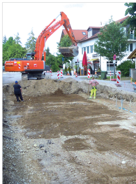
Aushubarbeiten beim Ausbau der Ortsdurchfahrt Schäftlarn. Häufig wird bei solchen Arbeiten festgestellt, dass die frostsichere Schicht eine erhöhte Chloridbelastung aufweist.
