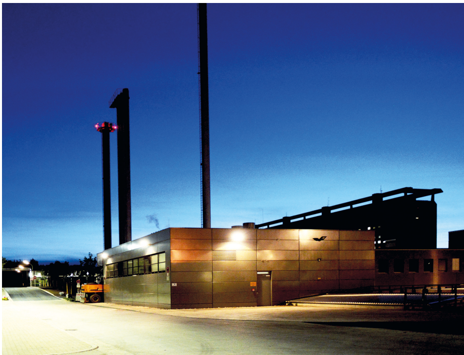
Das Heizhaus im Klinikum Großhadern. Die Anlagen für die Wärme- und Dampfversorgung des in den siebziger Jahren errichteten Klinikums mussten umfassend erneuert werden. © Klinikum der Universität München
