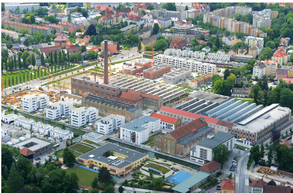
Das Gelände der Augsburger Kammgarnspinnerei (Aufnahme von 2014). Rechts in der Mitte liegen die drei Einrichtungen des Kulturgutspeichers, unten links liegt der hölzerne Färberturm. © Ulrich Wagner, Augsburger Allgemeine
