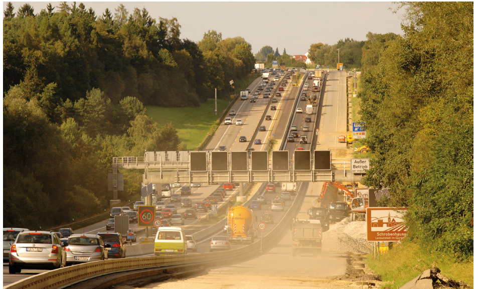
Baustelle an der A 9 bei Schrobenhausen. Um die Planung, Koordinierung und Durchführung von Arbeiten der Staatlichen Bauämter und Autobahndirektionen zukunftsgerichtet zu gestalten, wurde das ArbeitsstellenIntegrationsSystem ArbIS entwickelt. © Autobahndirektion Südbayern
