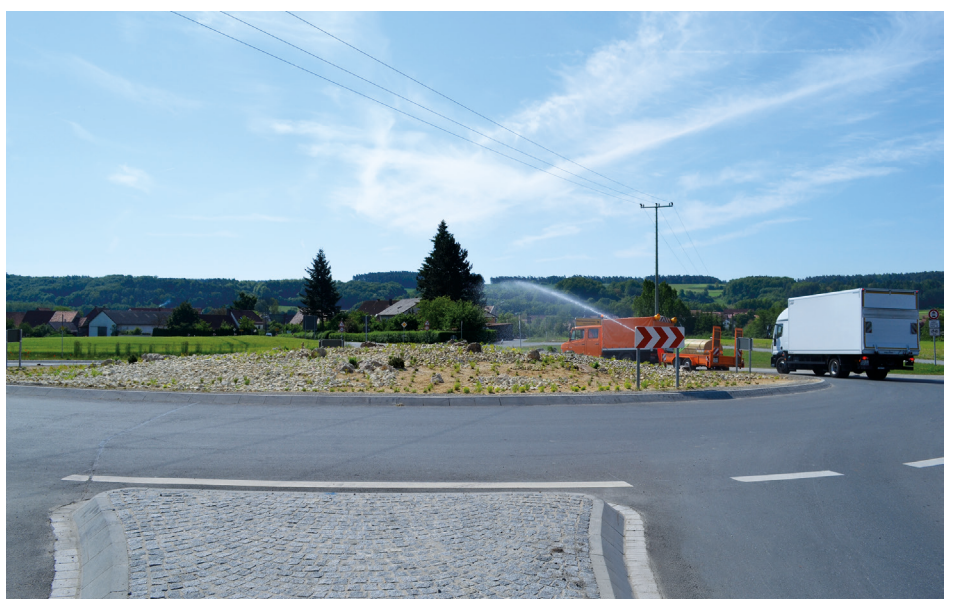
Oben: Der Kreisverkehrsplatz Aschbach-Ost mit konventioneller Rasenansaat vor der Umgestaltung. Mitte: Einbringen von Wurzelschutzvlies und Pflanzsubstrat nach dem Abtrag des Bodens. Unten: Bewässerung der Bepflanzung nach der Fertigstellung. © Staatl. Bauamt Bamberg
