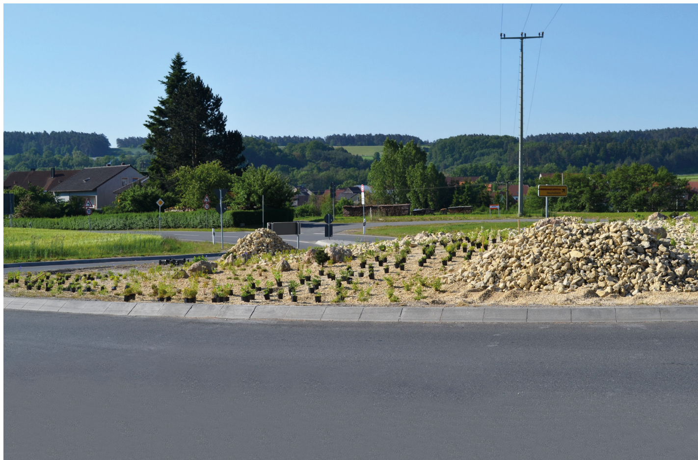
Bei der Umgestaltung des Kreisverkehrsplatzes Aschbach-Ost kamen Gabionensteine und Silbersommer-Stauden zum Einsatz. Die kostengünstige Pflanzenkomposition ‚Silbersommer‘ eignet sich gut für trockene, sonnige Standorte. © Staatliches Bauamt Bamberg
