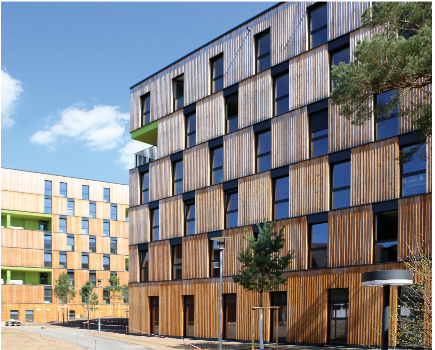
Zwei neue Wohnhäuser für Studenten auf dem Campus Süd in Erlangen. Raumhohe Fenster bestimmen die Fassadengestaltung. Die Studentenwohnanlage aus den 1970-er Jahren wurde zwischen 2013 und 2017 um sechs neue Häuser erweitert. Die Neubauten sind so angeordnet, dass sich Neu und Alt räumlich verzahnen und attraktive Freiräume entstehen. © Studentenwerk Erlangen/Nürnberg
