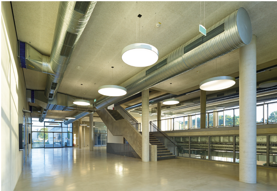
Oben: Das neue Zentrum für Naturwissenschaftliche Grundlagen, von Nordosten aus betrachtet. Der Neubau ist als Eigenplanung des Staatlichen Bauamts Freising entstanden. Unten: Blick in das Foyer des Hörsaalbaus © Eberhard Franke, München
