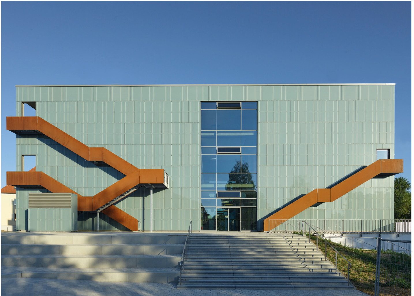
Zentrum für Naturwissenschaftliche Grundlagen, Haupteingang. Markante Gestaltungselemente der transluzenten Fassade sind die Fluchttreppen mit Wangen aus Cortenstahl. © Eberhard Franke, München
