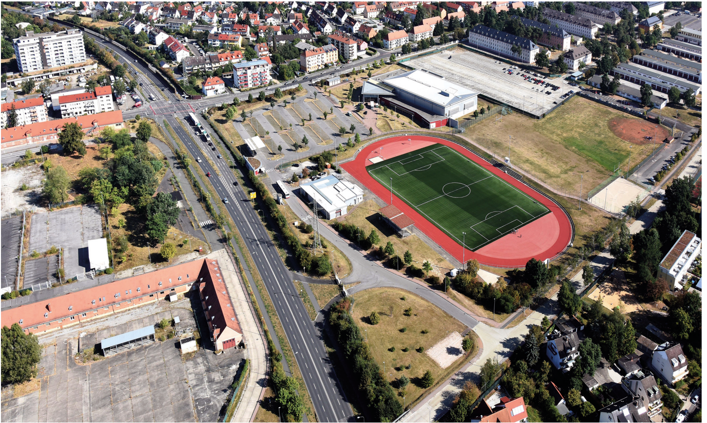
Die Sportanlagen des Aus- und Fortbildungszentrums in Bamberg. Um einen sicheren Betrieb in den Außenanlagen zu gewährleisten, mussten die Verkehrswege teilweise saniert werden. © Bundespolizei
