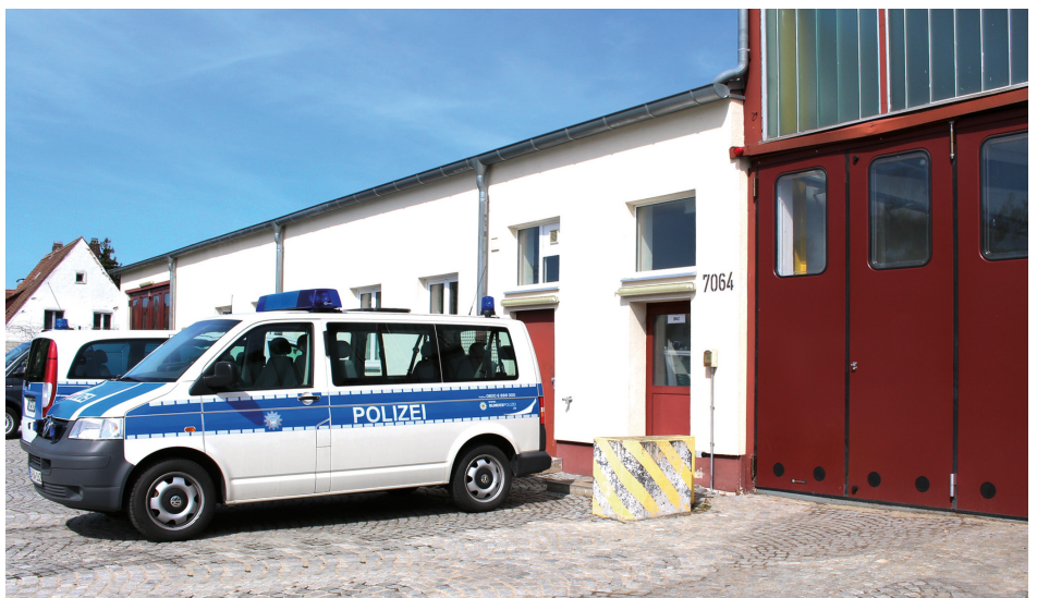
Oben: Typisches Unterkunftsgebäude mit Freianlagen auf dem früheren Warner-Barracks-Areal. Unten: Polizeifahrzeuge vor einem Bestandsgebäude in Bamberg. © Bundespolizei
