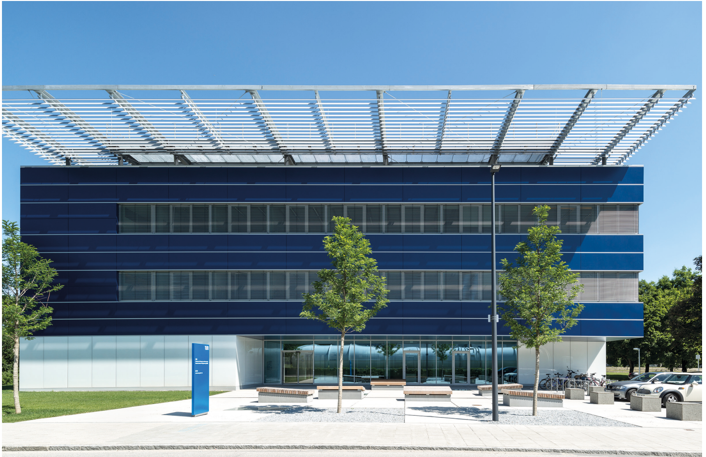
Haupteingang des neuen Zentrums für Energie und Information in Garching. Anfang April 2017 sind die Wissenschaftler in das Forschungsgebäude eingezogen. Sie widmen sich hier den Themen Energiegewinnung, -speicherung und -infrastruktur. © Oliver Jaist
