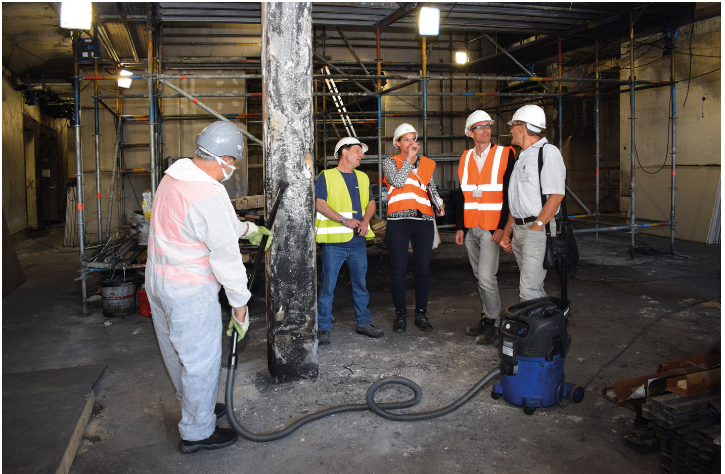
Helmut Schütz, Leiter der Obersten Baubehörde, (rechts im Bild) spricht im Foyer der Bavariathek mit Projektgruppenleiterin Anna-Maria Lanzinger und Alexander Bonfig, stv. Leiter des Staatlichen Bauamts Regensburg, über die Brandschäden. Im Vordergrund entfernt der Mitarbeiter einer Reinigungsfirma Ruß von einer Stütze. © Astrid Drebes
