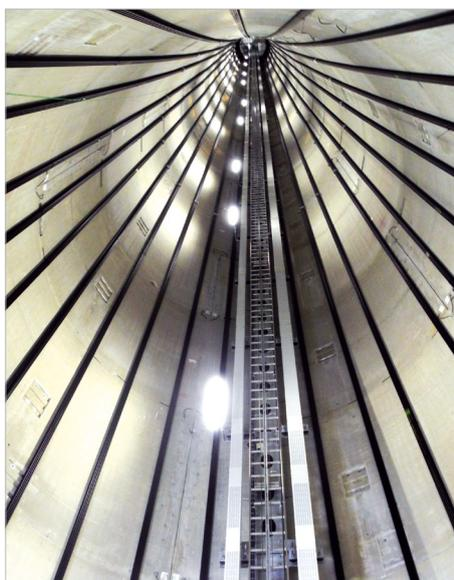
Windenergieanlage mit externer Vorspannung im Bauwerksinneren, Winnberg, Oberpfalz
