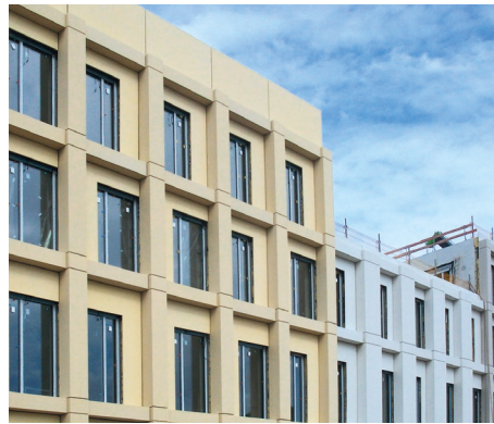
Stadtquartier „NeuerMarkt“ in Neumarkt / OPf. Fassade mit gefärbten, textilbewehrten Filigranbauteilen aus Beton © Firmengruppe Max Bögl
