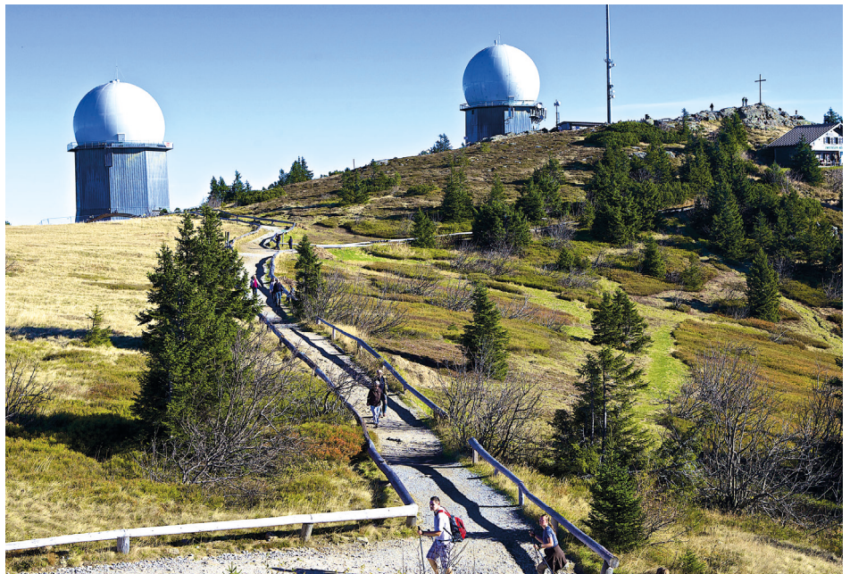
Die erneuerten Radome auf dem Großen Arber: Auf dem Gipfel steht die Radarkuppel zum Schutz eines Großraumradars der Luftwaffe, unter dem tiefer gelegenen Radom befinden sich Funkantennen © Frank Bietau, Lindberg
