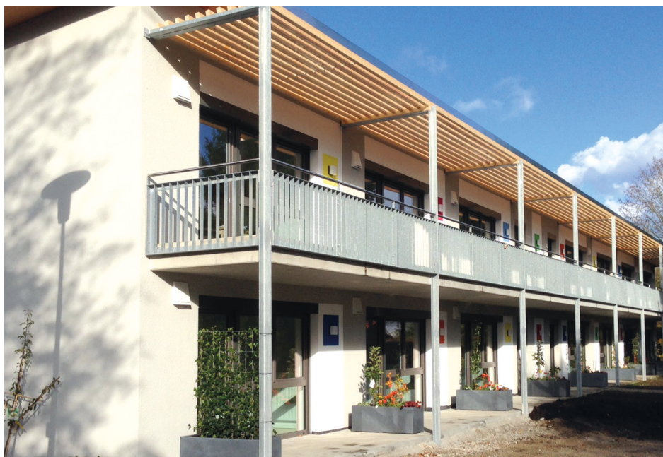
AOF-geförderte Apartments in Herzogsägmühle, Peiting © Baldauf Prill Architekten, Schongau
