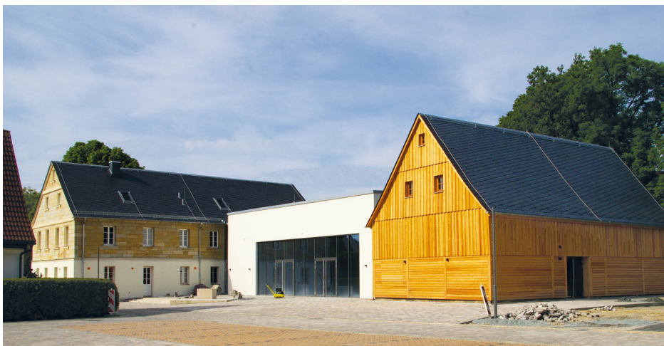
Das Anwesen nach der Sanierung, Bauherr: Gemeinde Mistelgau, Planung: Stiefler + Seiler Architekten © Stiefler + Seiler Architekten
