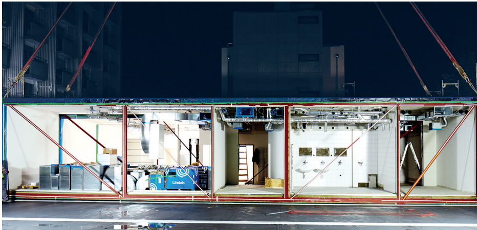
Vorfertigungsgrad: Technikraum, Umkleideraum D, Waschraum, Umkleideraum H (v.l.n.r.) © Sebastian Arlt
