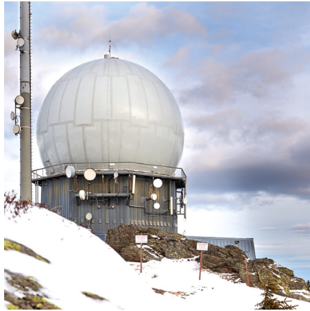
Radarstation zur Luftraumüberwachung auf dem Großen Arber © Marcel Peda, Passau
