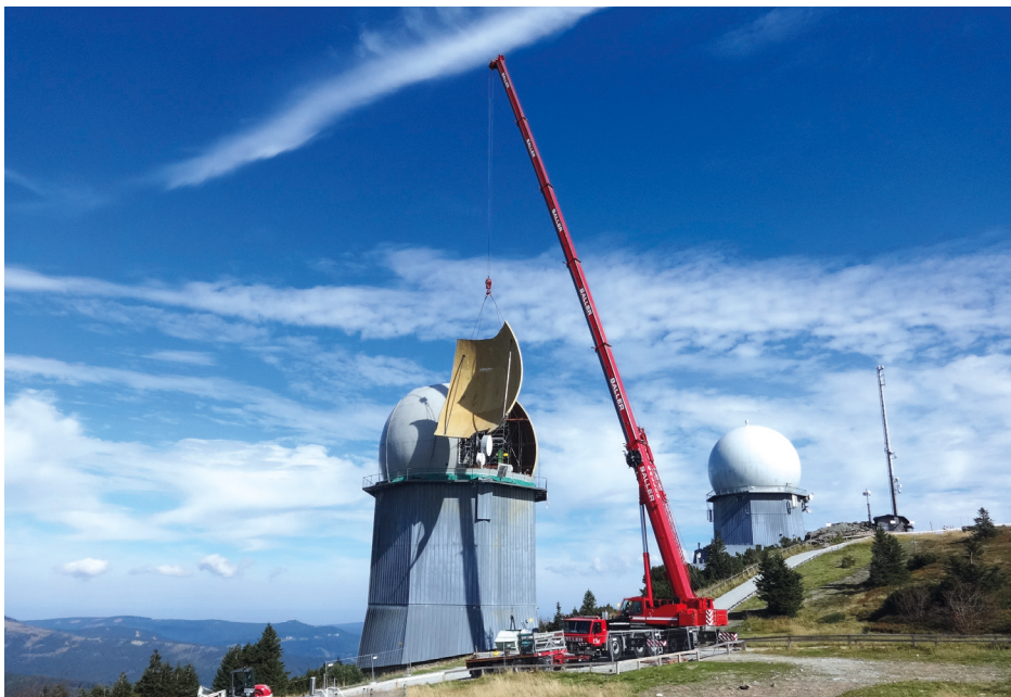
Die alte Kuppel des Radoms über den Funkantennen wird mit einem Autokran demontiert © Dieter Gogolin Bodenmais
