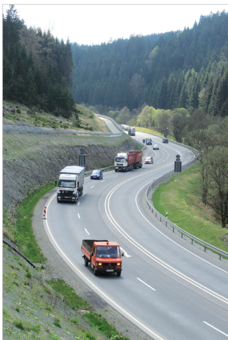
Die dreistreifig ausgebaute B 85 unter Verkehr
