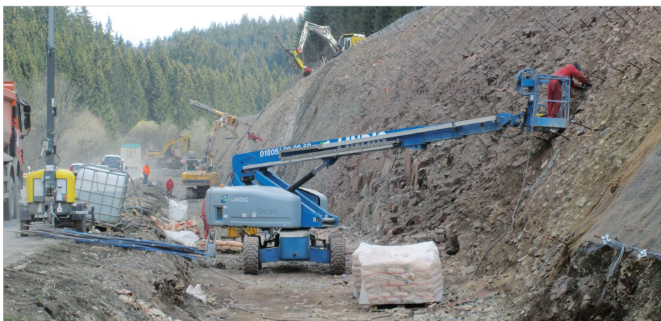
Ausbau der Bundesstraße 85. Oben: Bohrarbeiten für die Felsnägel Unten: Einbringen der Felsnägel und Befestigen des Stahlnetzes
