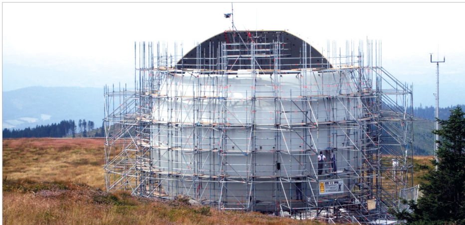
Auf einer Montageplattform unterhalb des Gipfels werden die Sandwichelemente der Radarkuppel zusammengesetzt © Staatliches Bauamt Passau
