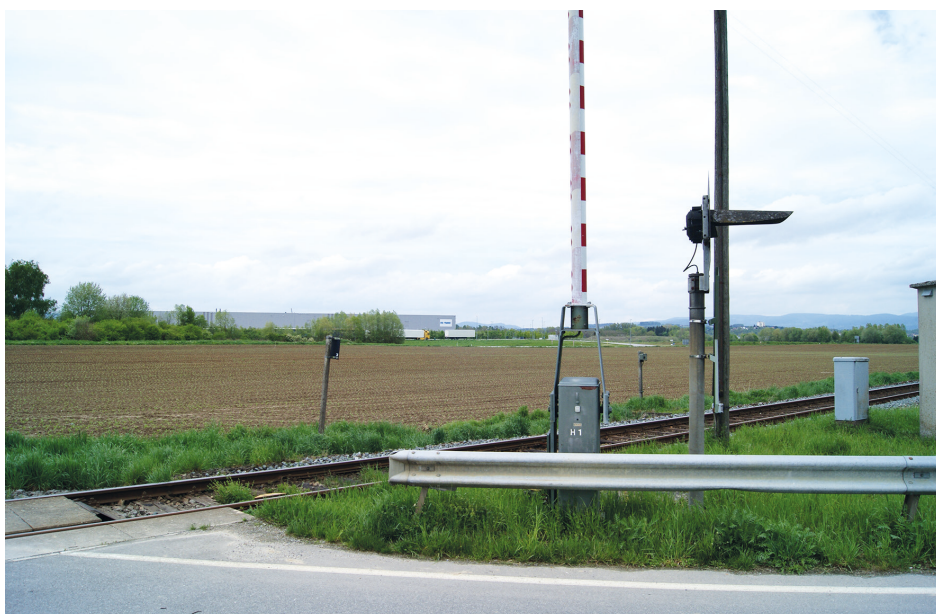
Oben: Graben (Lechfeld) Gewerbepark an der Strecke Augsburg - Landsberg ist eine der 60 bereits gebauten neuen Bahnstationen. Unten: Hier soll der neue Haltepunkt „Donauhafen Straubing-Sand“ entstehen. © Beide Fotos: Florian Liese
