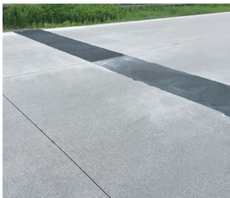
Entspannungsbereich in Asphaltbauweise © Autobahndirektion Südbayern
