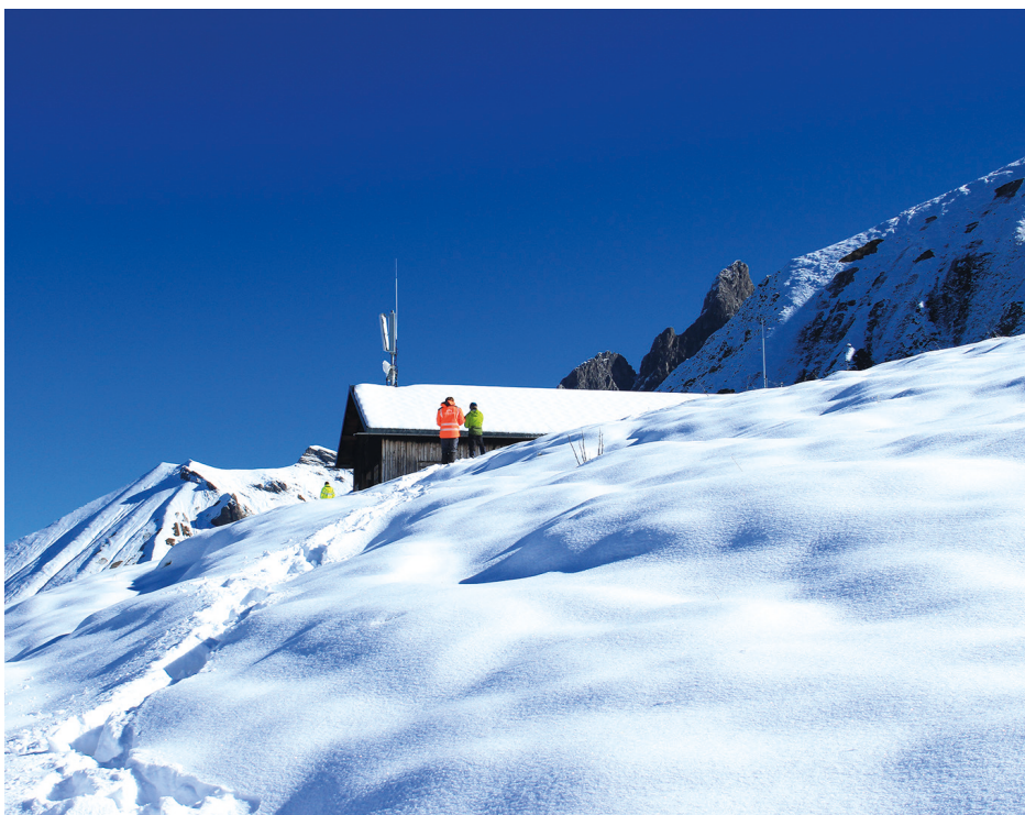
Oben: Die Sendeanlage Obersee am Königssee. Um die Anlage mit Strom zu versorgen, wurde mit der Verlegung eines 27 Tonnen schweren und über 3 Kilometer langen Seekabels im Königssee von St. Bartholomä bis zum Saletufer eine abenteuerliche Erschließungsmaßnahme realisiert. Das Seekabel wurde mit einer Geschwindigkeit von 8 Metern pro Minute verlegt und von Tauchern und Robotern begleitet © Staatliches Bauamt Traunstein Unten: Auf dem Dach der Enzianhütte bei Oberstdorf wurde auf einer Seehöhe von 1800 m ü. NN eine der höchstgelegenen Sendeanlagen in Bayern errichtet. © Staatliches Bauamt Kempten
