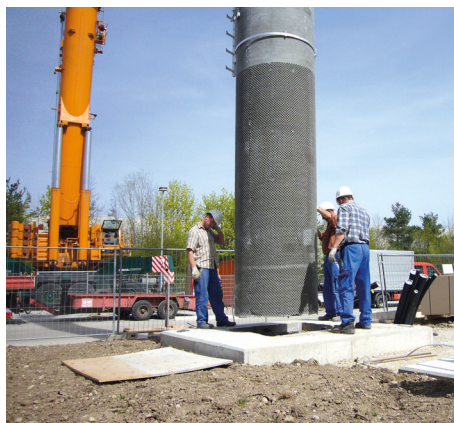
Links: Stahlgitterkonstruktion am Standort Oberstaufen © Staatliches Bauamt Kempten Rechts: Kranmontage eines 60 m hohen Schleuderbetonmasten in Gersthofen. Präzision und exakte logistische Vorbereitung der Baustellen sind entscheidende Voraussetzungen für eine erfolgreiche Montage. Der Einsatz der Transportgeräte und die Professionalität der beauftragten Spezialunternehmen sind dabei beeindruckend. © Staatliches Bauamt Augsburg
