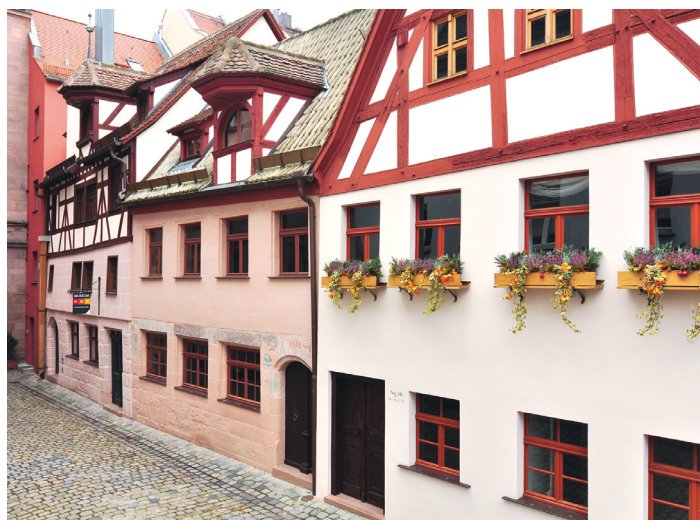
Handwerkerhäuser Kühnertsgasse 18-22 nach der Sanierung © Uwe Kabelitz
