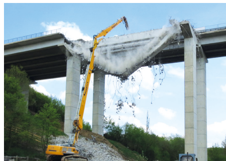
Oben: Die alte Bräubachtalbrücke Unten: Abriss der alten Brücke © Roman Wagner
