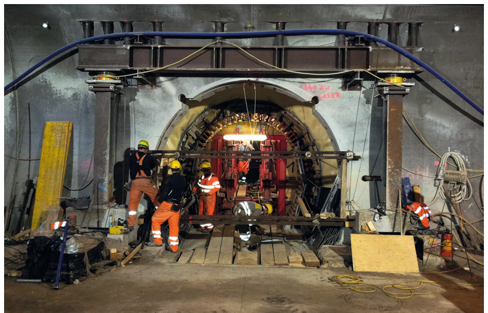
Tunnel Farchant, B2 – Ein vorgespanntes, stählernes Portal stützt die Tunnelschale der Verkehrsröhre temporär ab. © Autobahndirektion Südbayern
