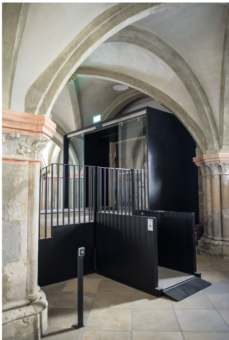
St. Ulrich in Regensburg wurde 2014 zur barrierefreien Erschließung mit einem Aufzug ausgestattet. © Staatl. Bauamt Regensburg
