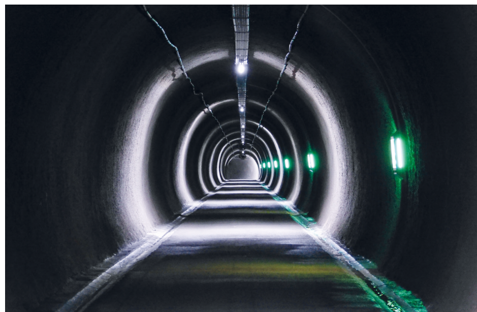
Oben/Unten: Grenztunnel Füssen, A7 – Im Südabschnitt wurde ein parallel verlaufender Rettungsstollen errichtet. Unten: Blick in den Rettungsstollen. © Beide Fotos: Autobahndirektion Südbayern
