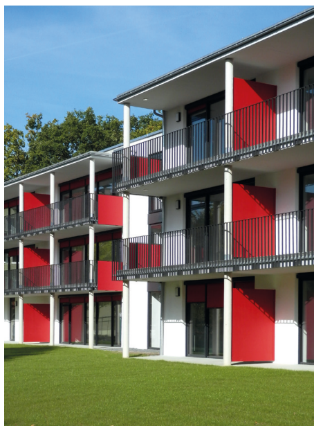
Laubenganghaus in Altstadt: Gestaffelte Baukörper mit vorgelagerter Balkonzone © Albert Dischinger
