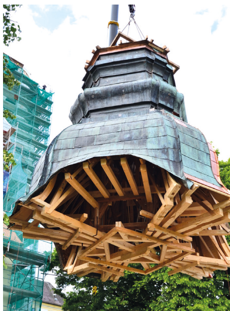
Der restaurierte Turmhelm wird in zwei Teilen wieder auf den Kirchturm gehoben. © Staatl. Bauamt Passau
