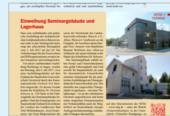
Einweihung Seminargebäude und Lagerhaus an der SFS Geretsried aus der brandwacht, Heft 4/2017.
