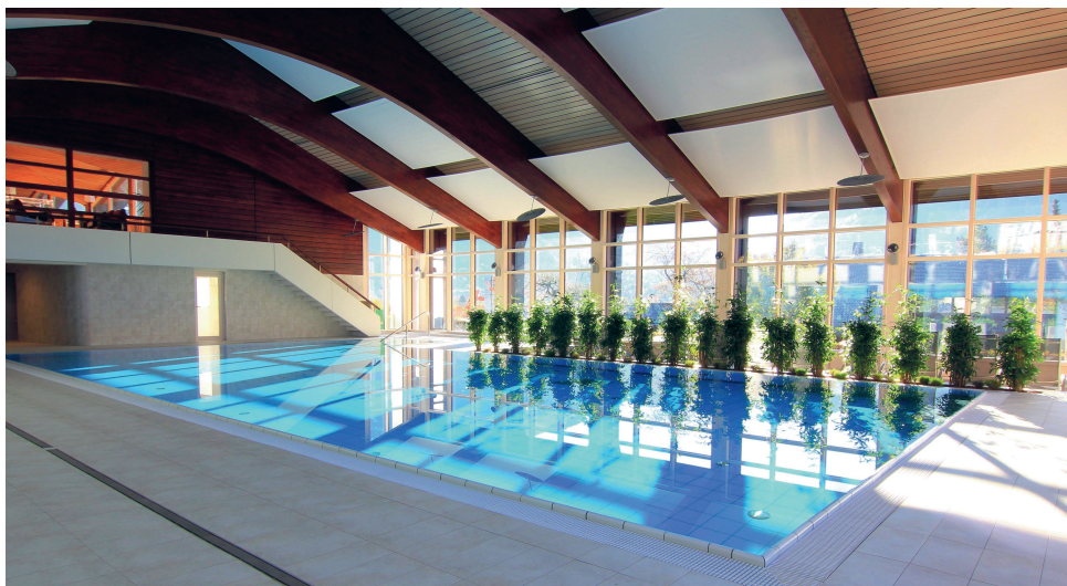
Das sanierte Hallenbad konnte bereits im November 2012 wieder eingeweiht werden. Aufn.: BFH.
