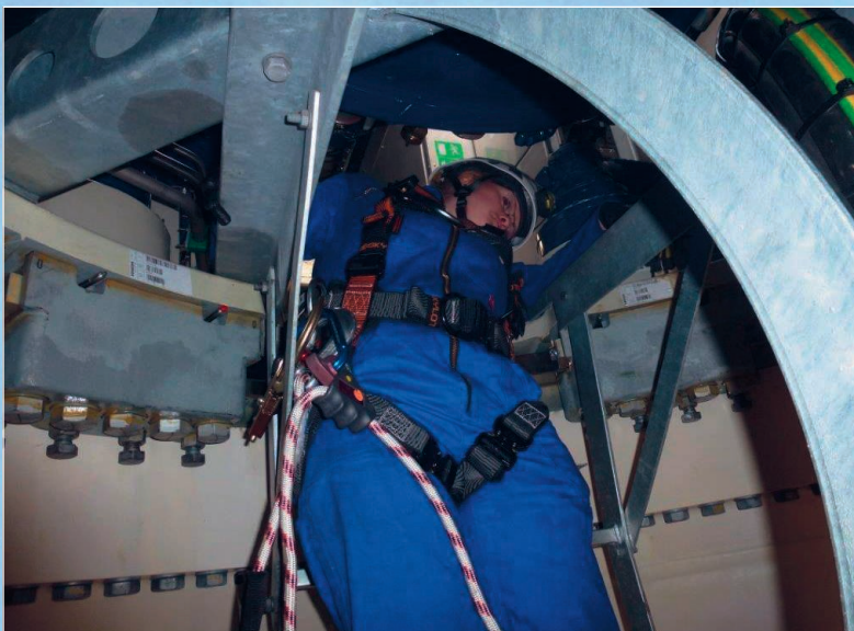
Die Enge im Maschinenhaus der WEA und die langen Zugangswege und Zeiten stellen die Rettungskräfte vor große Probleme.
