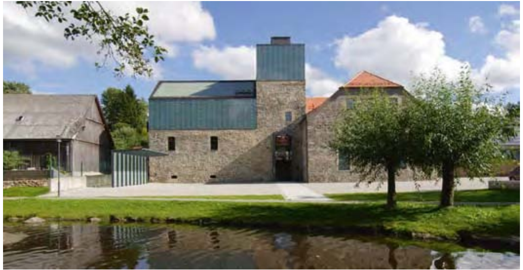
Centrum Bavaria Bohemia (CeBB) im ehemaligen Kommunbräuhaus in Schönsee/Oberpfalz, Preisträger des Bayerischen Bauherrenpreises 2009
