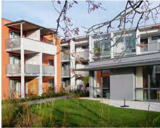
Der Neubau der Wohnanlage in Bamberg-Gaustadt zeichnet sich durch ein vielfältiges Wohnungsangebot und ein auf breiter Basis angelegtes Betreuungskonzept aus.
