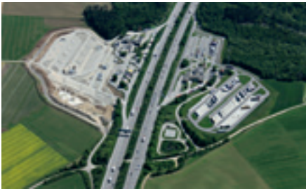
Mehr Stellplätze für LKW: Umbau und Erweiterung der Tank- und Rastanlage Vaterstetten am Autobahnring München.
