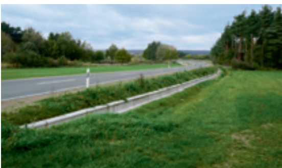
Nachrüstung von Amphibiendurchlässen und Leiteinrichtungen an der Staatstraße 2259 Birnbaum – Rezelsdorf (Lankreis Neustadt/Aisch) für die Laichwanderung zu den Reischbach-Teichen.
