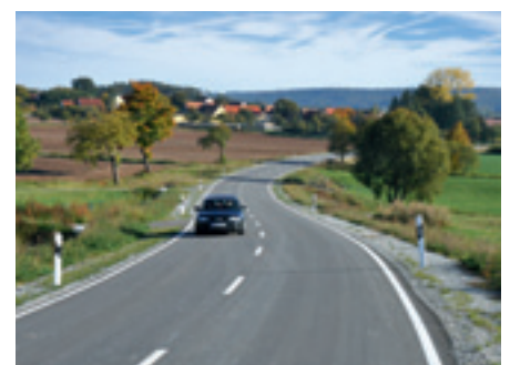
Das Konjunkturpaket II des Bundes hat zahlreiche dringend notwendige Erhaltungsmaßnahmen im Staatsstraßennetz ermöglicht, wie hier auf der St 2253 südlich von Bad Windsheim in Mittelfranken
