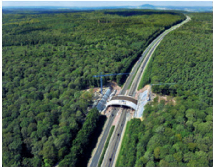
Grünbrücke im Rehauer Forst bei Oberthulba im Bau. Das Bauwerk verbindet künftig die beiden bisher durch die A 7 getrennten Waldteile.
