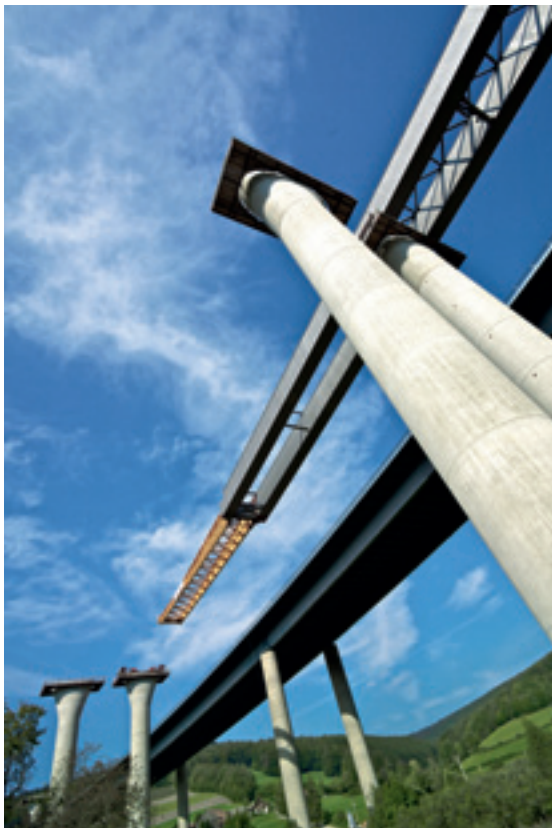
Ersatzneubau der Sinnthalbrücke im Zuge der A 7 bei Bad Brückenau in der Röhn. Das neue 755 Meter lange und bis zu 44 Meter hohe Bauwerk mit Gesamtkosten von 52 Millionen € soll 2013 in Betrieb genommen werden.
