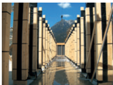
Neubau Finanzamt Garmisch-Partenkirchen, Errichtung der tragenden Holzkonstruktion
