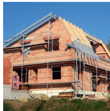
Einfamilienhaus im Rohbau
