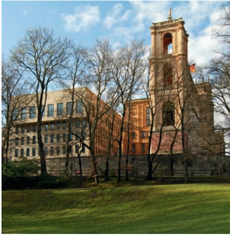
Erweiterungsbau Bayerischer Landtag
