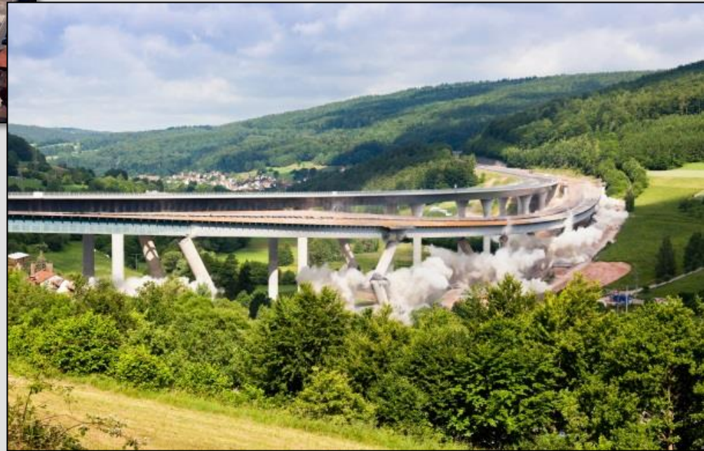
Sprengung alte Sinntalbrücke
