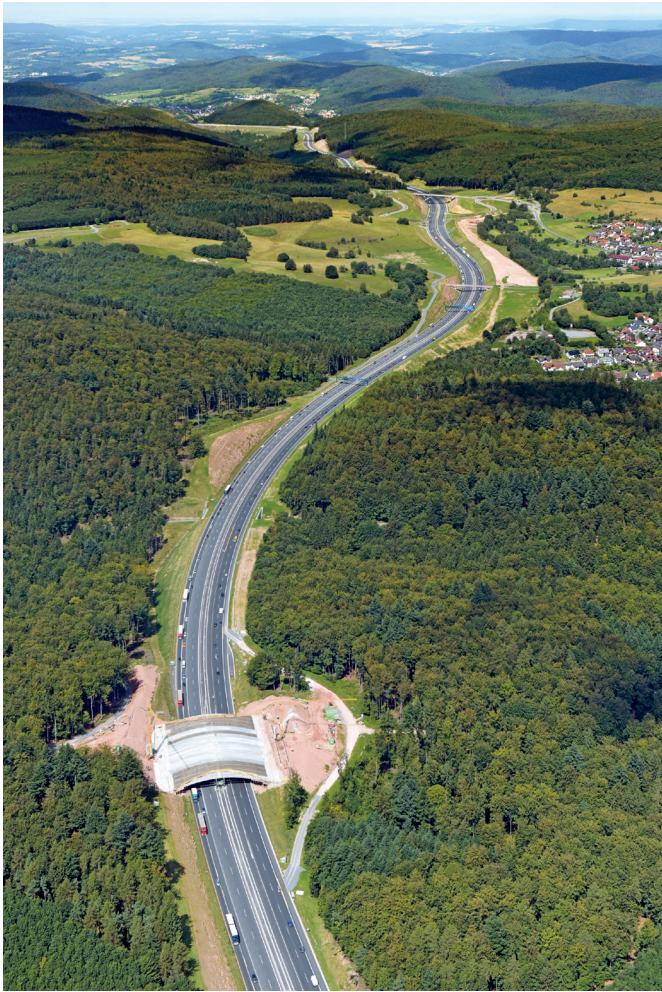
Oben: Bau der Grünbrücke im Spessart bei Weibersbrunn. Foto: Hajo Dietz, Nürnberg Luftbild
