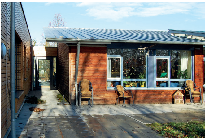
Oben: Westansicht des Erweiterungsbaus. Die Architekten wählten eine massive Holzrahmenkonstruktion für das Gebäude.
