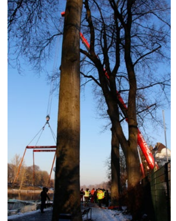
Beengte Platzverhältnisse erschwerten das Aufstellen eines Krans.
