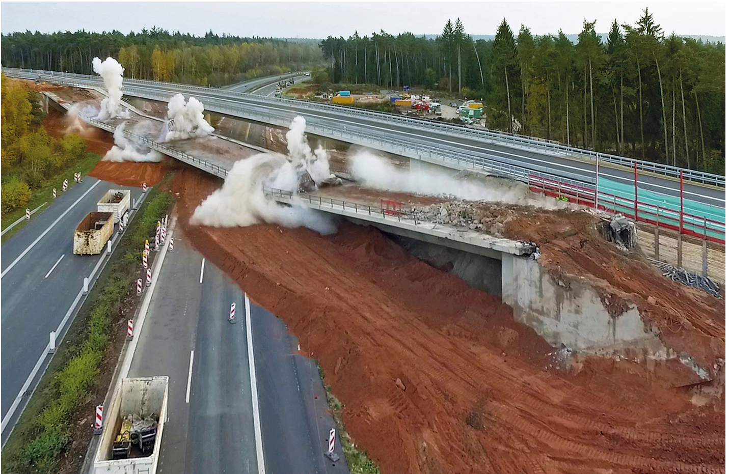
Deutschlands erste „Intelligente Autobahnbrücke“ ist seit Oktober 2016 in Betrieb. Im November 2016 wurde die alte Brücke gesprengt. Die zweibahnige Autobahntangente Frankfurt – München musste im Rahmen der Abbrucharbeiten gantztägig gesperrt werden. © Hajo Dietz
