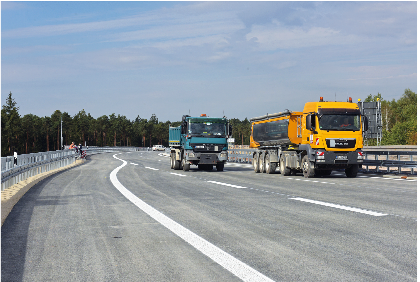
Zur Kalibrierung der Messtechnik wurden u. a. LKW-Fahrten durchgeführt. Die Messgeräte zeichnen den Verkehr einschließlich des Baustellenverkehrs auf. Die Auswertung startete im Dezember 2016. © Hajo Dietz
