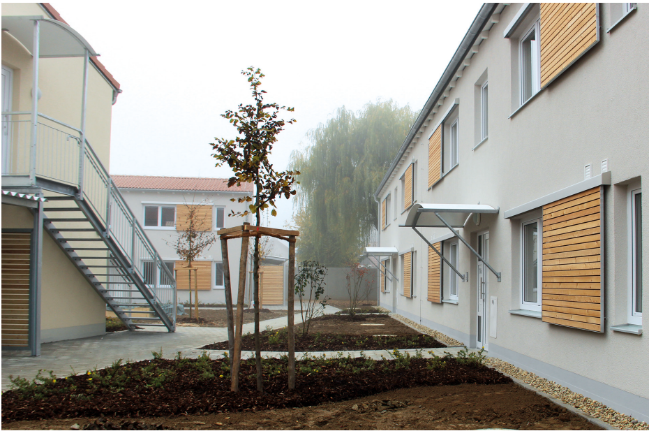
Wohnanlage in Massivbauweise in Straubing. Diese Anlage in Niederbayern ist im Rahmen des staatlichen Sofortprogramms entstanden, mit dem der Staat vorrangig auf eigenen Grundstücken kurzfristig Wohnungen für anerkannte Flüchtlinge und einheimische Bedürftige plant, baut und verwaltet. © Anna Rieser
