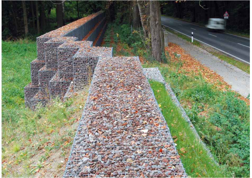
Die fahrbahnnahe Lärmschutteinrichtung zeigt, dass Gabionen vielfältig einsetzbar sind. Durch die Unterstützung der Forschungsarbeit hat die Bayerische Staatsbauverwaltung erheblich zur Weiterentwicklung von Gabionen beigetragen. © Fa. Hoy-Geokunststoffe GmbH
