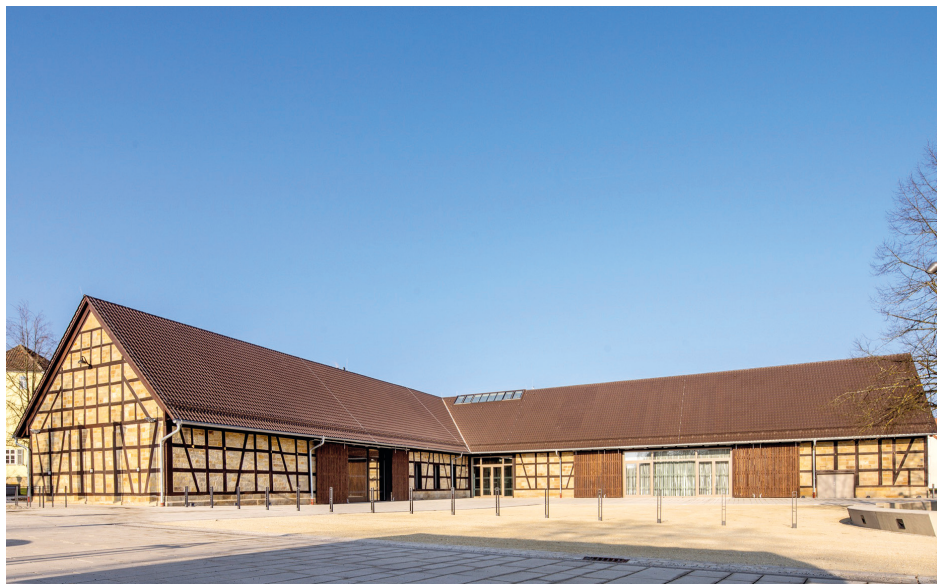
Der Westflügel der Staatsdomäne Sonnefeld. Das ehemalige Salz- und Streugutlager wurde zu einer Kultur- und Veranstaltungshalle umgebaut. © Sascha Kletzsch, München
