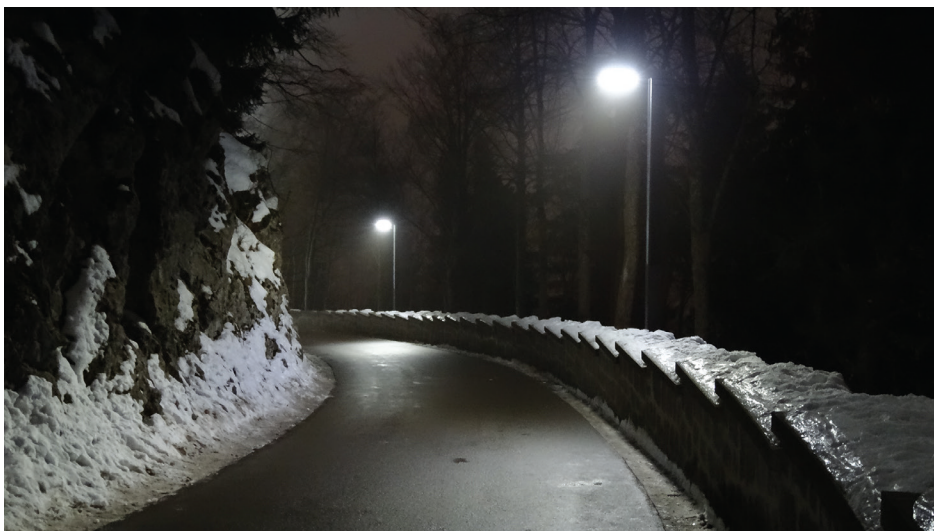
Die neue Beleuchtung am Schloss Neuschwanstein. Die integrierten Photovoltaik-Module sind in der Lage, auch ohne direkte Sonneneinstrahlung ausreichend Energie zu erzeugen.
