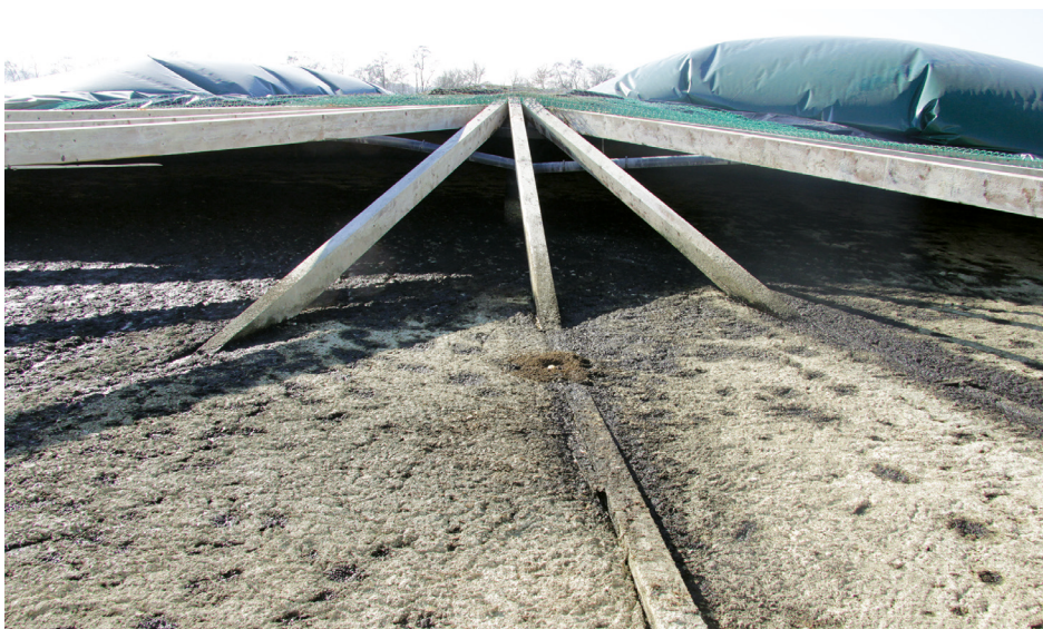
Oben: Zwischenböden aus Holz verhindern das Absinken der Kunststoffmembran in das Gärsubstrat. Mitte: Im Zuge der Entschwefelung des Biogases lagern sich Schwefelkristalle zentimeterdick an den Holzbalken ab. Es kommt zur chemischen Zersetzung, das Holz wird spröde. Unten: Einsturz einer Holzdeckenkonstruktion in Folge eines Sprödebruchs. © www.ingkrause.de
