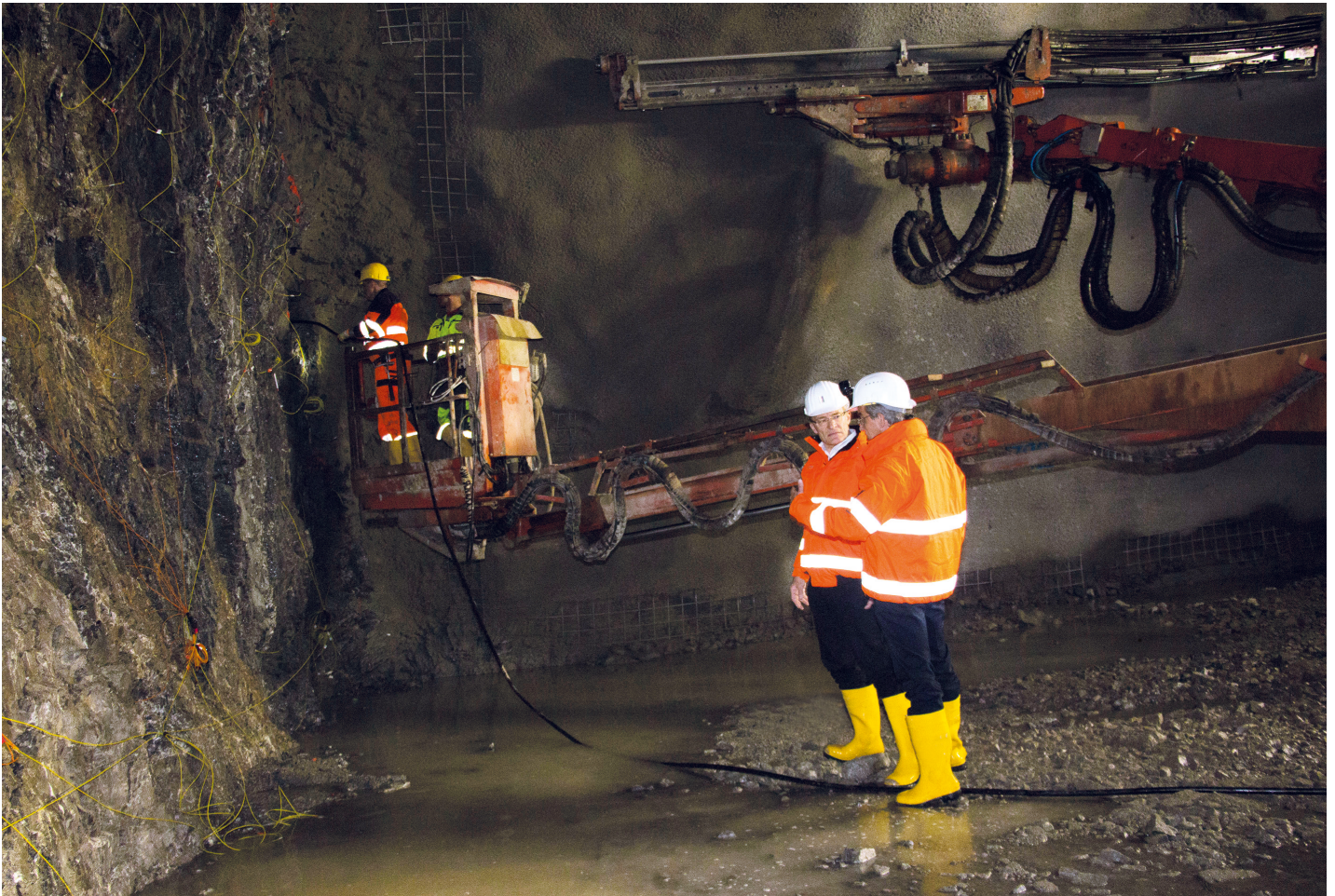
Helmut Schütz, Leiter der Obersten Baubehörde, macht sich mit Professor Dr.-Ing. Uwe Willberg, Autobahndirektion Südbayern, ein Bild vom Stand der Bauarbeiten im Tunnel Oberau. Im Hintergrund bereiten Mineure eine Sprengung vor. © Oberste Baubehörde
