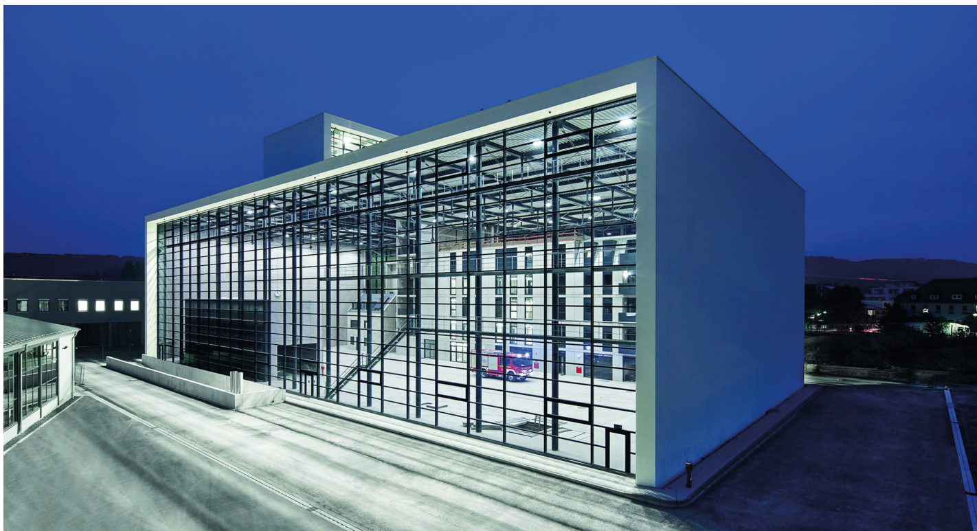
Neubau der Feuerwehrschnule in Würzburg. Unter der Projektleitung des Staatl. Bauamts Würzburg hat das Büro „gmp Architekten von Gerkan, Marg und Partner“ eine imposante stützenfreie Übungshalle geplant. Unter einem Dach werden dort auf 5.500 m 2 komplexe Einsatzszenarien simuliert. ©Tom Bauer, Staatl. Feuerwehrschnule Würzburg
