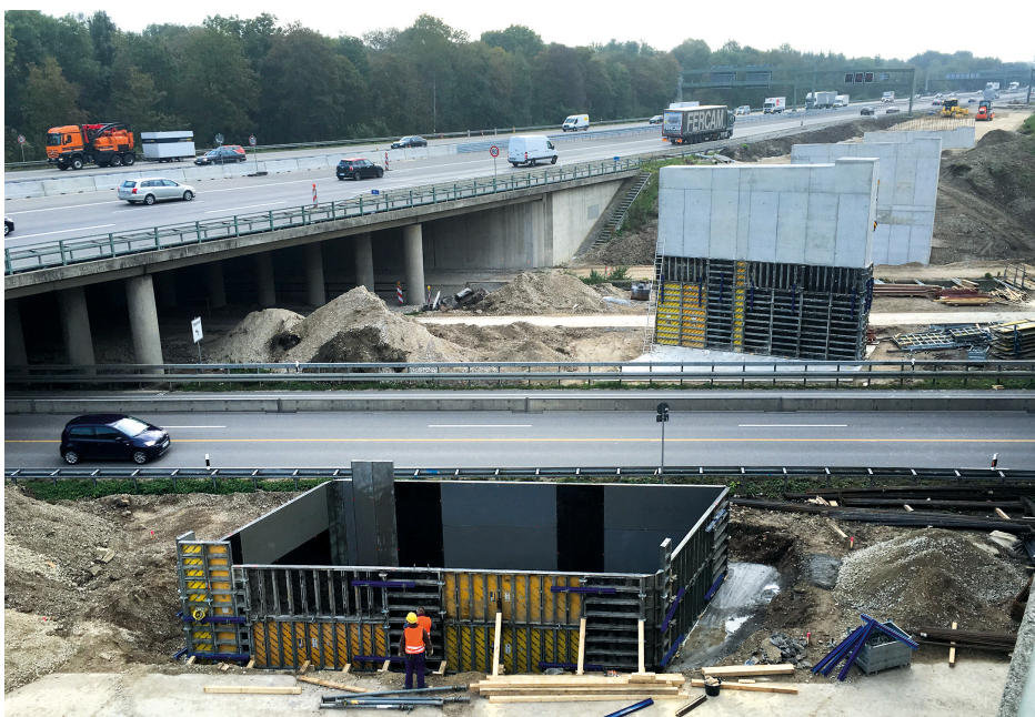
Bau einer Behelfsbrücke für die Rampe von der A 9 auf die A 99. Fahrbahnverbreiterungen und Mittelstreifenüberfahrten sorgen dafür, dass die Verkehrsteilnehmer während des Ausbaus der A 9 durchgehend sechs Fahrstreifen nutzen können. © ABDS
