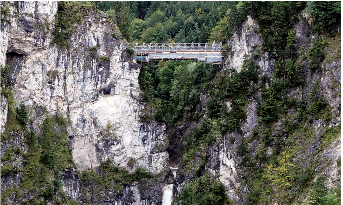
Blick vom Schloß Neuschwanstein auf die eingerüstete Marienbrücke über der Pöllatschlucht © Staatl. Bauamt Kempten
