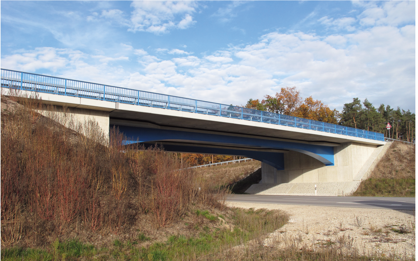
Die Pilotbrücke Greißelbach im Landkreis Neumarkt in der Oberpfalz wurde beim Deutschen Ingenieurbaupreis mit einer Anerkennung gewürdigt. Die Besonderheit der 32 Meter langen Brücke ist der neuartige Überbau, der sich aus einzelnen Segmenten aus selbstverdichtendem Beton zusammensetzt. Dass die Auswechslung und direkte Befahrbarkeit der Segmente ermöglicht wurde, bewertete die Jury als herausragende Ingenieurleistung. © Staatliches Bauamt Regensburg
