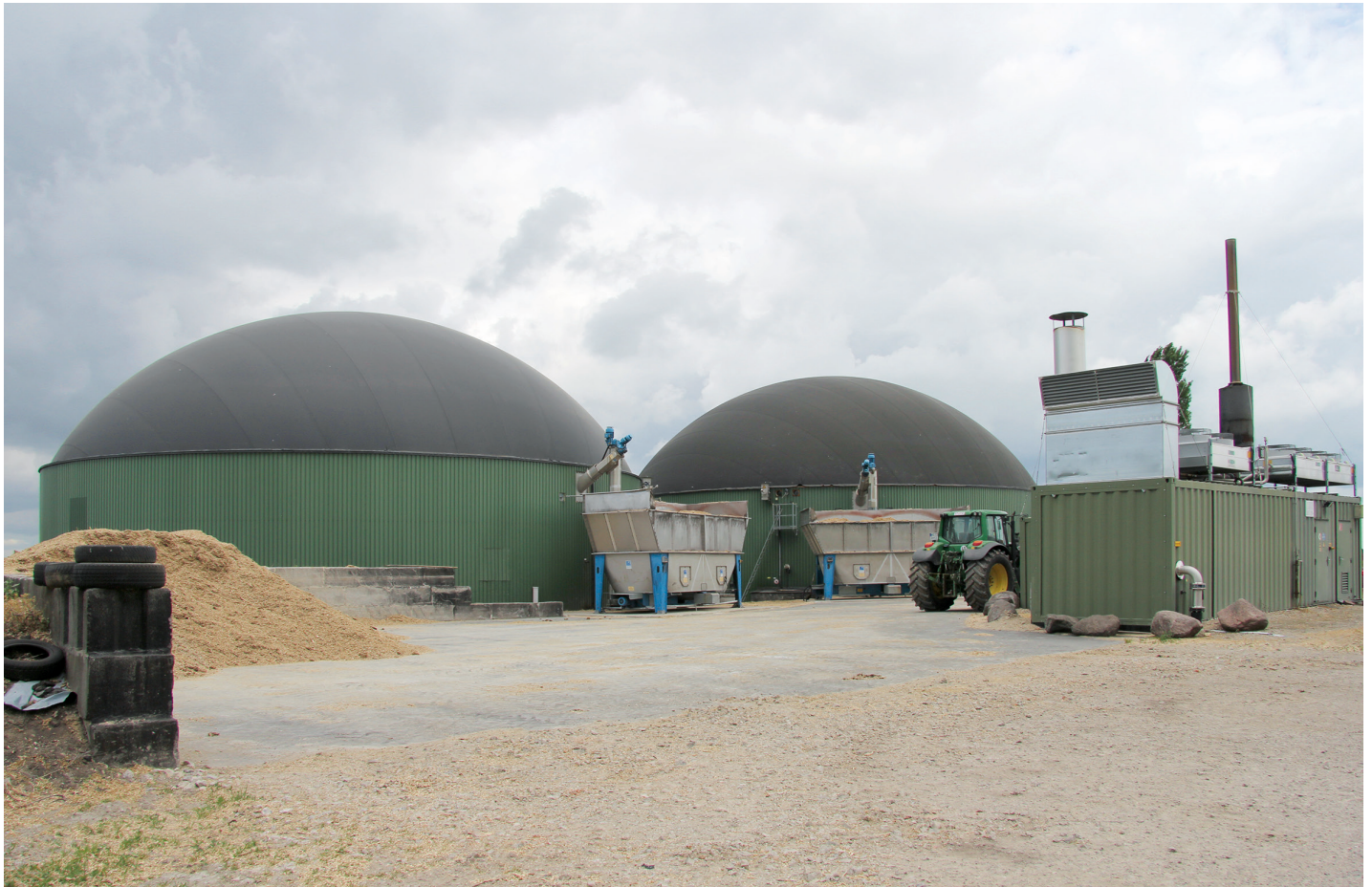
Biogasanlagen leisten einen wichtigen Beitrag zur Stromversorgung. Biogas wird in Betonbehältern, sogenannten Nassfermentern, erzeugt und gespeichert. Sie werden durch eine – meist aufgeblähte – Kunststoffmembran abgeschlossen. © www.ingkrause.de
