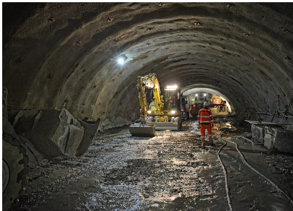
Im Tunnel wird rund um die Uhr unter Hochdruck gearbeitet. „Der West-Tunnel ist mit Abstand die beste Lösung für Oberau“, sagt Peter Imminger, Bürgermeister der Gemeinde Oberau. © Fischer
