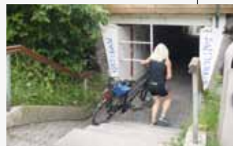
Treppe und zu steil geneigte Rampe am Zugang zur Unterführung, Querungsinsel im Bereich des Durchgangs zum See schränkt durch unebenes Pflaster Barrierefreiheit ein
