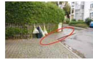
Engstelle knapp über 1 m mit Verschwenkung und Kleinsteinpflaster, welche die Barrierefreiheit einschränken
