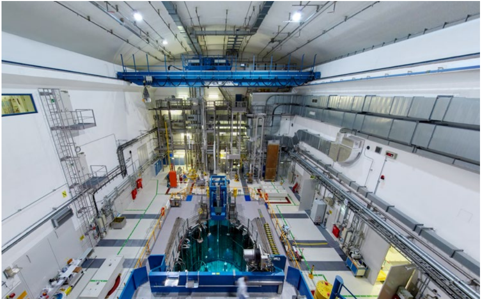
Das Reaktorbecken fasst 700 m 3 Wasser und ist nach oben zur Reaktorhalle hin offen. Über eine fahrbare Brücke können Mitarbeiter:innen mit Handhabungsgeräten in die Tiefe gelangen und so die Aufgaben im Reaktorbecken durchführen. © Bernhard Ludewig
